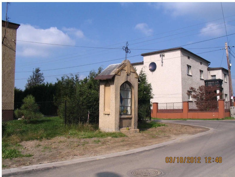
Kapliczka Zarzeckiego przed rewitalizacją
